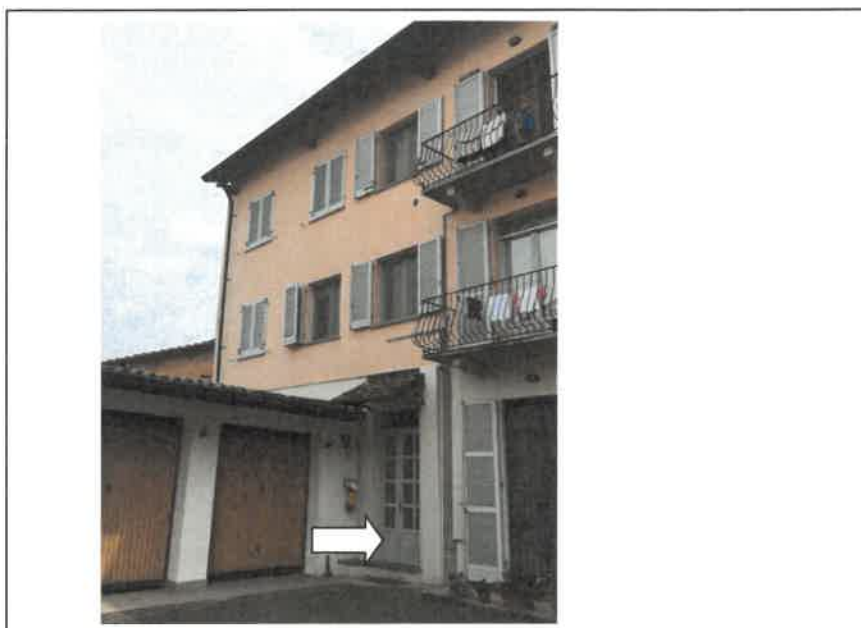
Fotografia n.5 : ingresso scala "A" – corte interna
