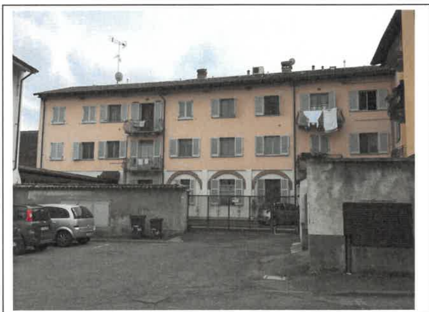
Fotografia n.2 : Prospetto nord – interno cortile
