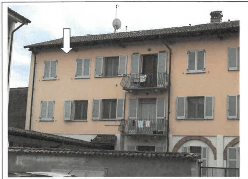
Fotografia n.4 : Individuazione appartamento in oggetto (sub. 7)
